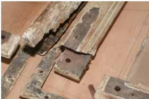
**9** Die gesteckten und unverleimten Holzverbindungen historischer Holzfenster ermöglichen den gezielten Austausch schadhafter Einzelteile und damit sehr substanzschonende Instandsetzungsmaßnahmen. (Stuttgart – Plieningen, Bauernhaus)
