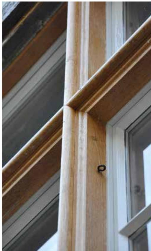
**48–50** Eine Alternative zum Fensterersatz bietet der Einbau von Sonderisolierverglasungen mit geringen Abmessungen in den denkmalwerten Fensterbestand, auch wenn Substanzverluste an den Fensterflügeln in Kauf genommen werden müssen. (Systemskizze Scheibenaustausch/Mühlhausen-Tiefenbronn, Schloss/Inzighofen, Stift Inzighofen)
