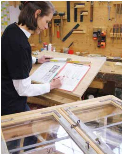
6 Denkmalgerechte Instandsetzungskonzepte und handwerkliche Fensterreparaturen erfolgen nach fachtechnischen Voruntersuchungen durch Fachbetriebe und einer schriftlichen Dokumentation, die vor Ort oder in der Werkstatt gefertigt wird.
