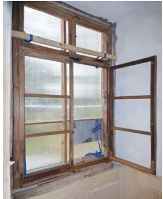
**13** Müssen Fenster zur Reparatur ausgebaut werden, so ist es notwendig, die Fensteröffnung mit einem provisorischen Schutz über die Bauzeit zu versehen. Diese Baustellenfenster schützen die überholten Fenster vor Bewitterung, bis der Schlussanstrich erfolgt ist. (Homburg a.d. Ohm, Schloss)
