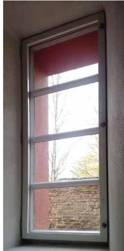
**26** Einfachfenster mit Einfachverglasung mit innen aufgedoppeltem und verschraubtem Holzrahmen zur Herstellung eines Verbundfensters (Mühlhausen-Tiefenbronn, Schloss)
