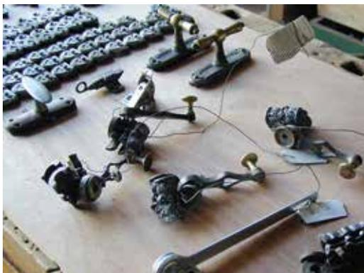
**10** Beschläge werden zur Überarbeitung des Holzrahmens abgenommen. Lose Beschläge müssen mit einer Kennzeichnung versehen werden, damit sie nach der Holzreparatur wieder dem ursprünglichen Fenster zugewiesen werden können. (Esslingen, ehem. Schelztor-Gymnasium)
